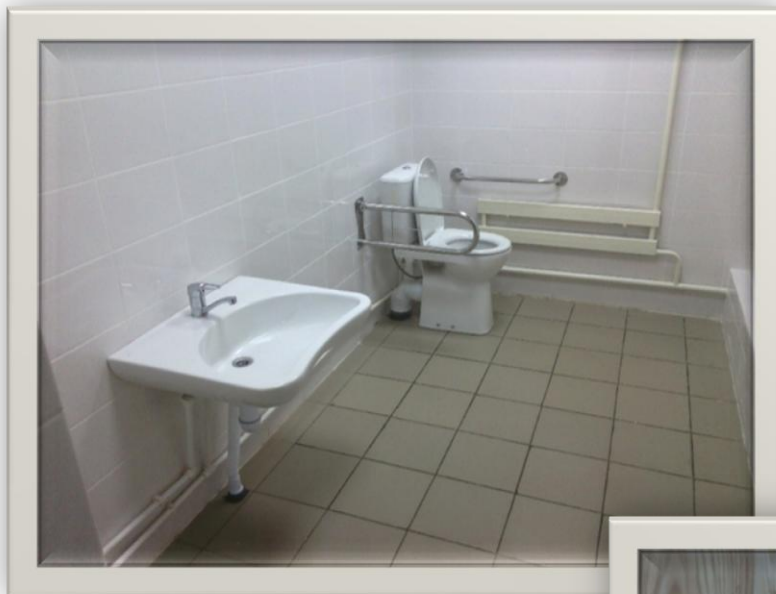
Капитальный ремонт туалетной комнаты
