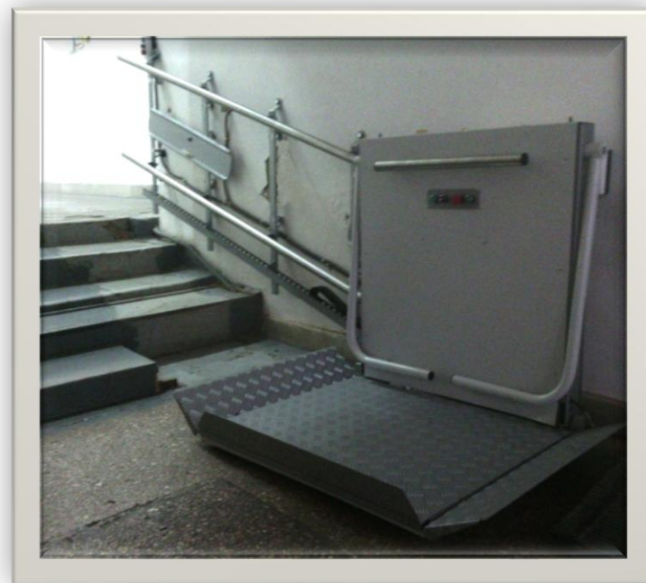
Наклонный подъемник внутри здания
